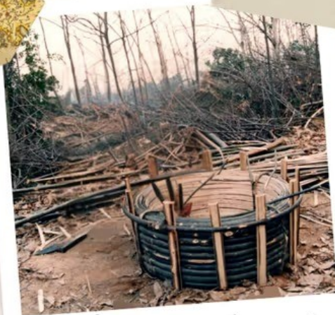
roder en construcció
